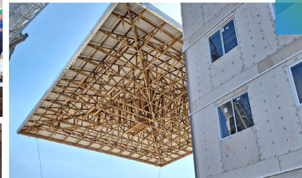
2024: Montagem de cobertura no canteiro de obras.
