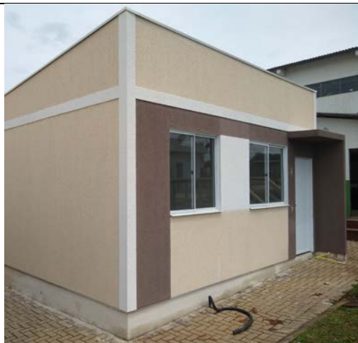
Figura 34 – Acabamentos externos de casa térrea isolada com painéis de oitões e platibanda.
