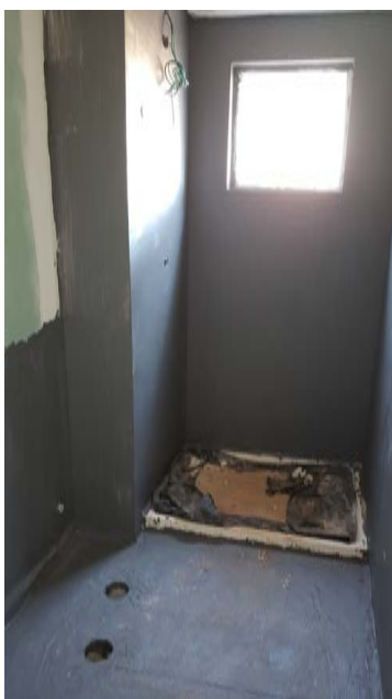
Figura 16 – Banheiro com aplicação de impermeabilização.
