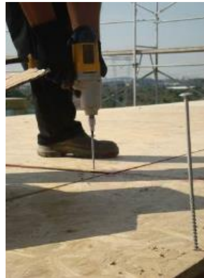
Figura 25 – Fixação do quadro estrutural de entrepiso na travessa superior da parede.
