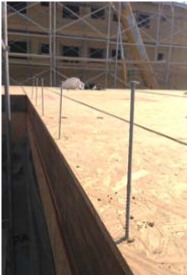
Figura 24 – Fixação do entrepiso.
