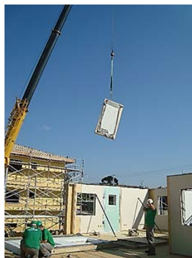
Figura 23 – Movimentação e montagem das paredes.
