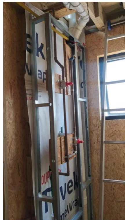
Figura 22 – Shaft instalado em obra.
