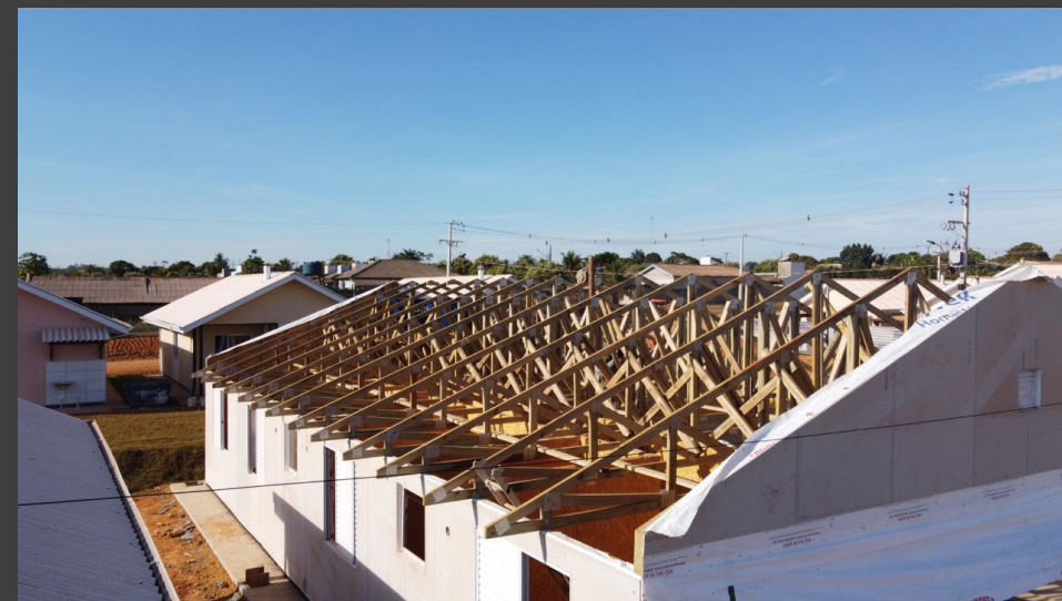
OBRA RESIDENCIAL DARDANELOS - TECVERDE
