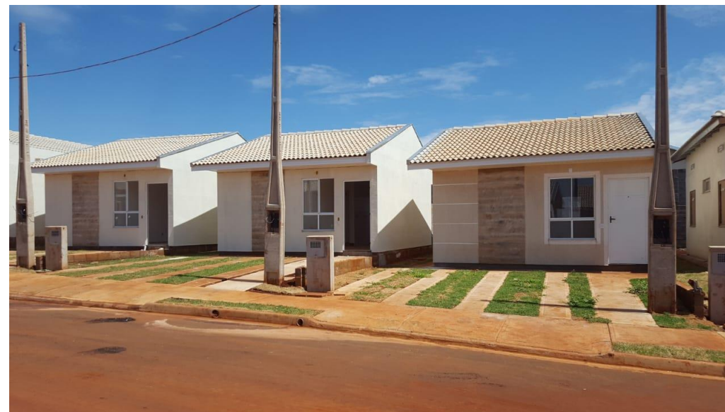
OBRA MACAÚBA GARDEN - TECVERDE
