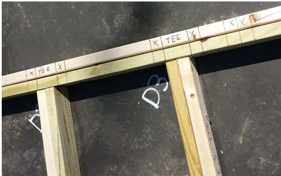
Figura 4.19 – Soleiras inferior e superior devidamente posicionadas e com marcação dos elementos verticais.
