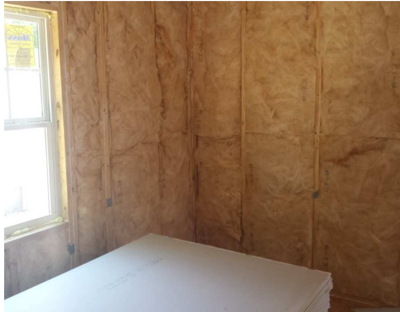
Figura 4.28 – Paredes preenchidas com lã de vidro para isolamento térmico.
