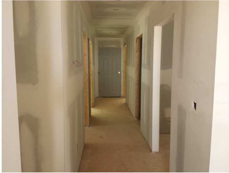
Figura 4.29 – Revestimento interno com gesso acartonado.
