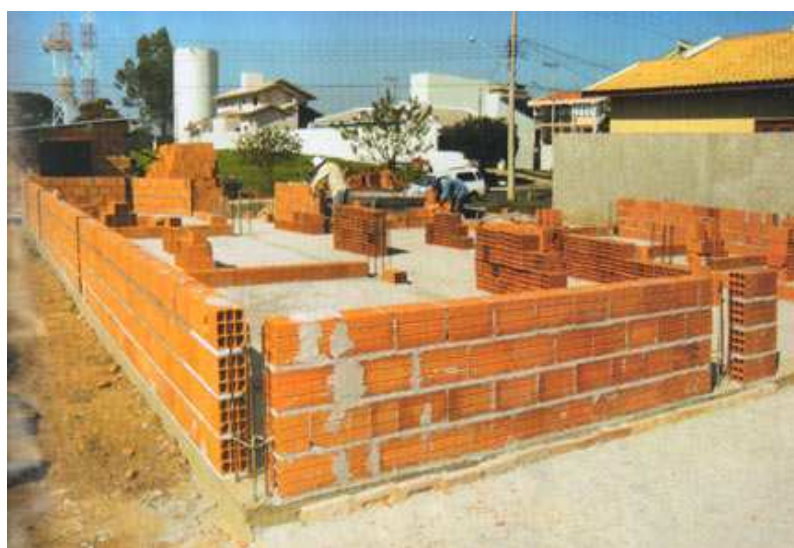
Figura 3.1 – Edificação sendo construída no Sistema Construtivo Convencional.
