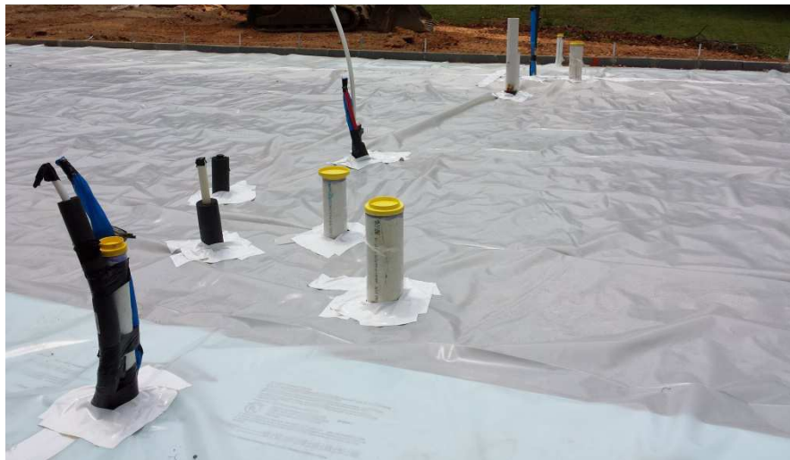
Figura 4.18 – Tubulações de água e esgoto localadas e executadas previamente a concretagem da laje de fundação.
