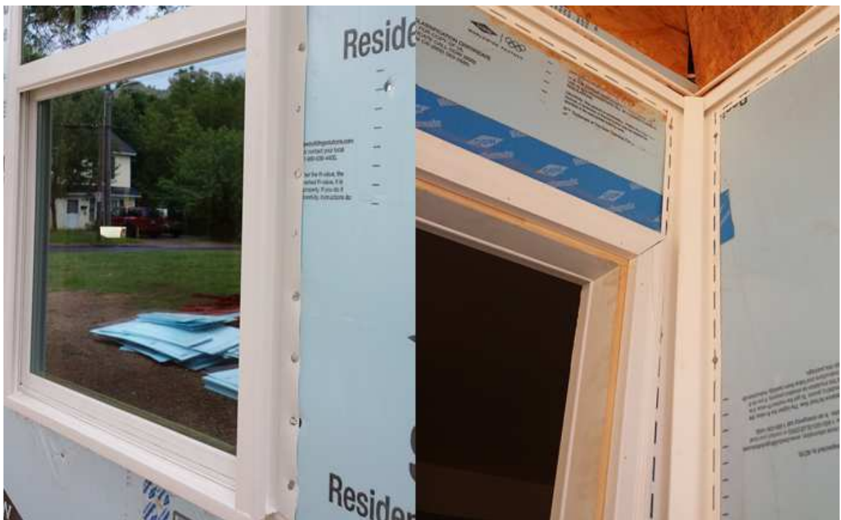
Figura 4.24 – Peças acessórias executadas e prontas para receber as peças de Siding.
