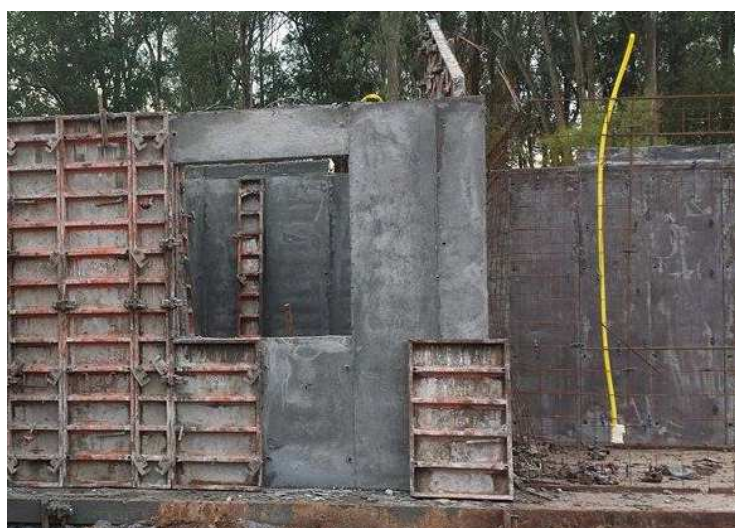
Figura 3.2 – Edificação sendo construída no Sistema Construtivo de Paredes de Concreto moldadas no local.
