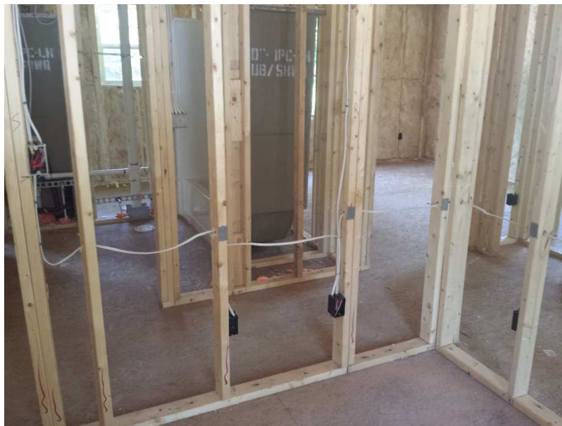
Figura 4.27 – Sistemas elétrico e hidrossanitário embutidos nas paredes.
