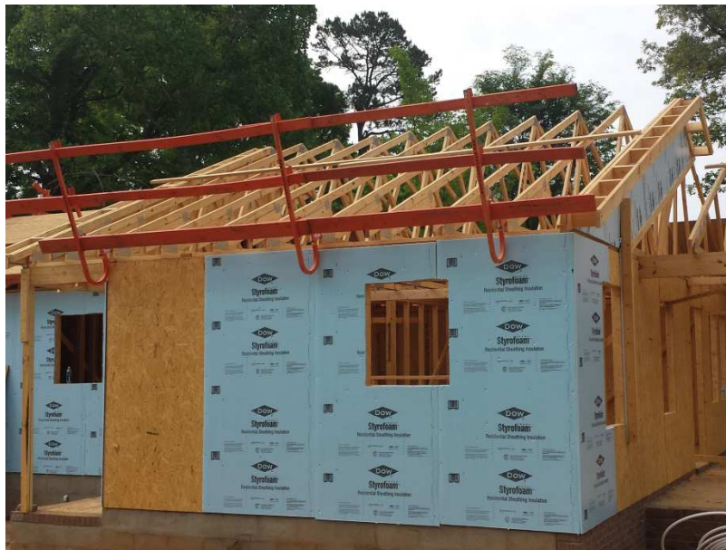
Figura 4.23 – Execução da camada de impermeabilização da estrutura com painéis.
