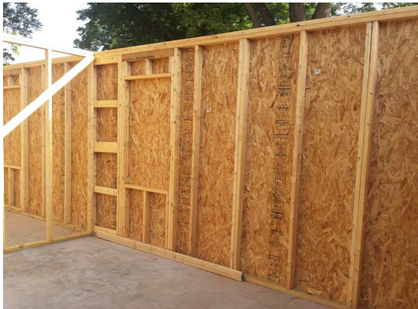
Figura 4.22 – Parede montada com ossatura e contraventamento.
