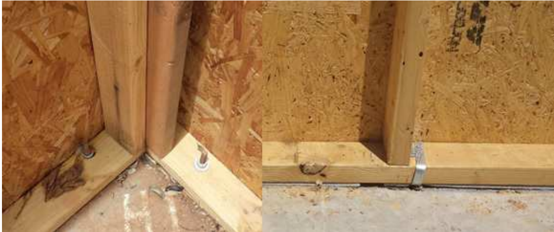
Figura 4.20 – Fixação das paredes à laje de fundação por meio de fitas metálicas e parafusos de ancoragem.
