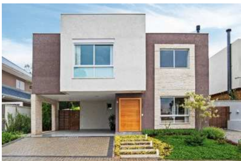
Figura 4.9 – Edificação em Wood Framing construída pela empresa Tecverde. [TECVERDE(20--)]
