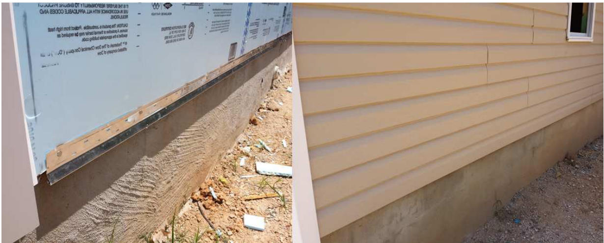
Figura 4.26 – Procedimento de instalação de revestimento externo em PVC.
