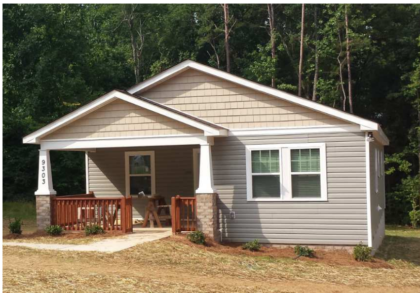
Figura 4.10 – Residência Unifamiliar em Wood Frame com Revestimento em Siding Vinílico.
