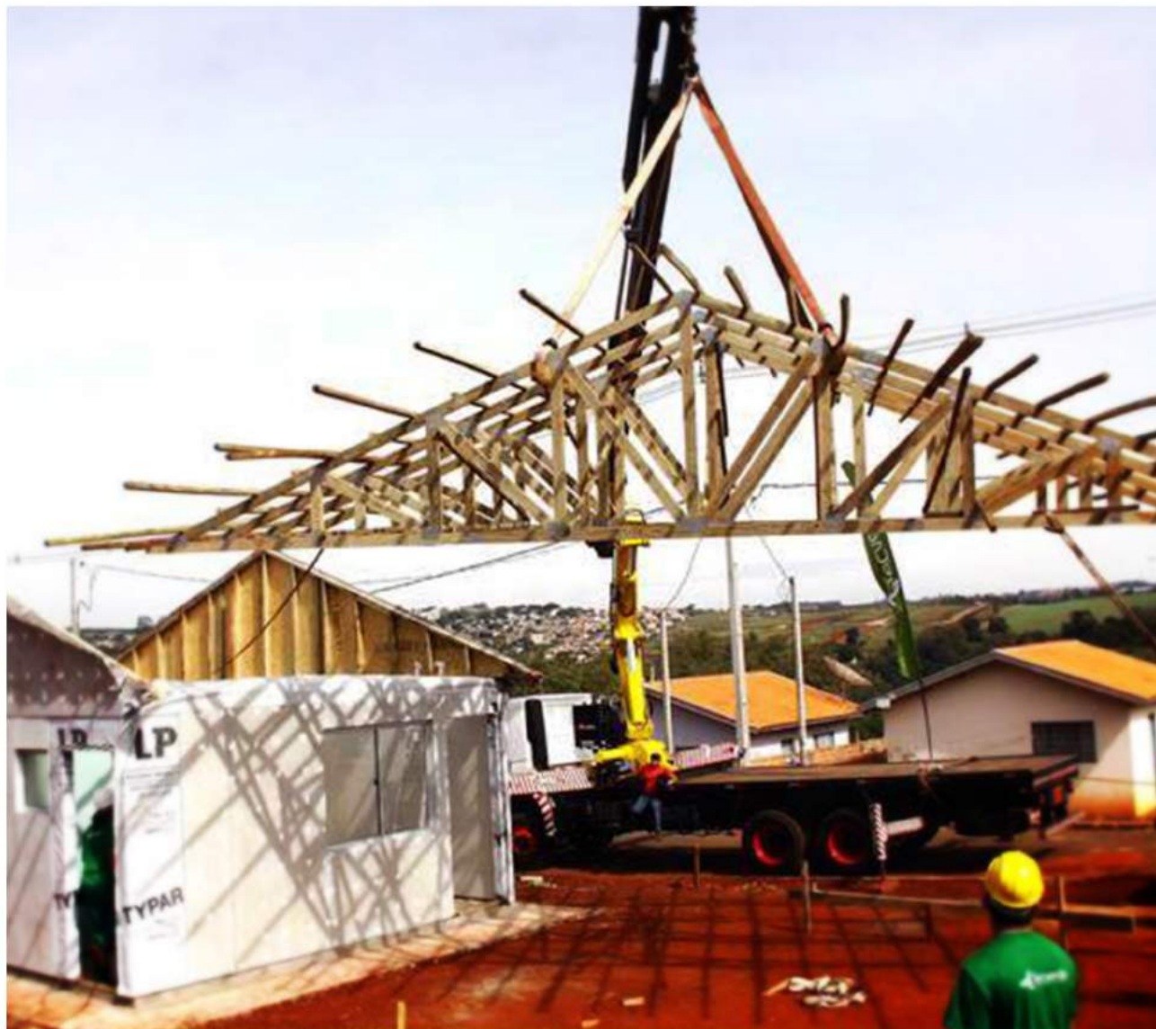
Figura 27 – Montagem da Cobertura
