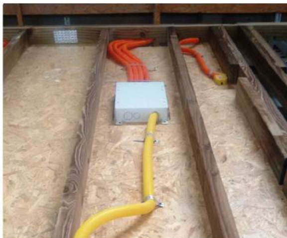
Figura 32 – Conduíte e caixa elétrica sendo instalada dentro do painel na fábrica Fonte: Tecverde Engenharia S/A
