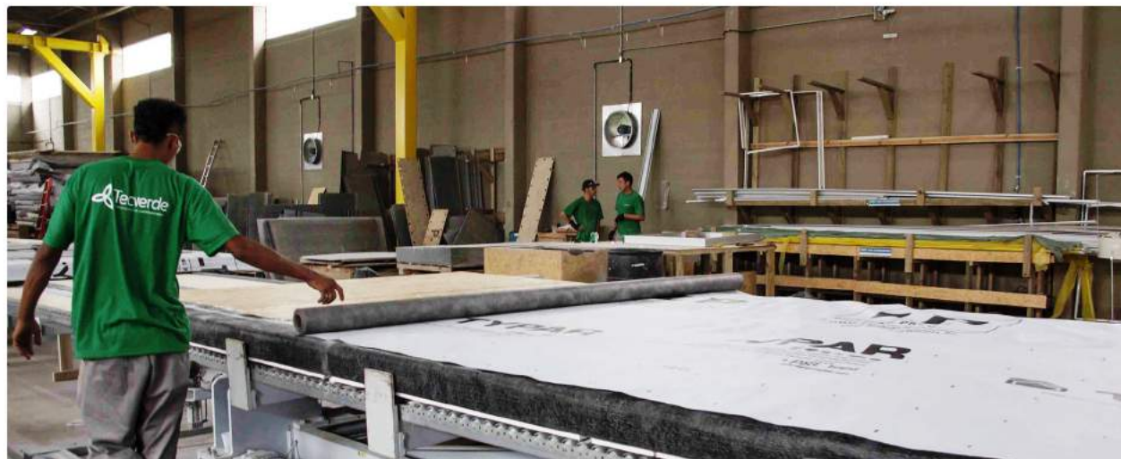
Figura 22 - Membrana sendo colocada sobre o painel já chapeado com OSB Fonte: Tecverde Engenharia S/A
