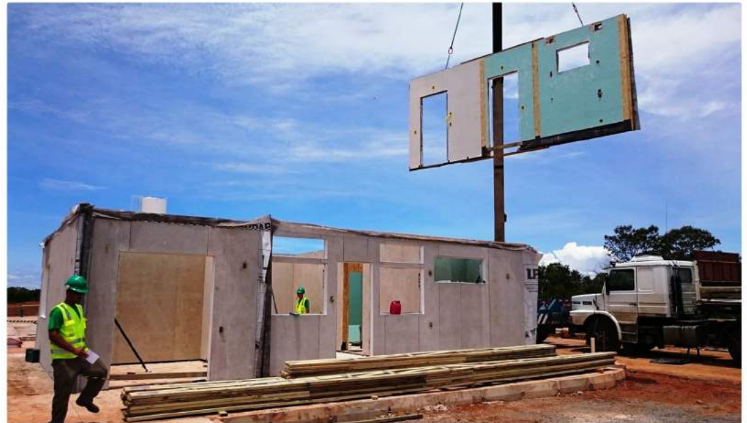
Figura 26 – Painéis sendo içados no canteiro de obra durante a montagem da edificação Fonte: Tecverde Engenharia S/A
