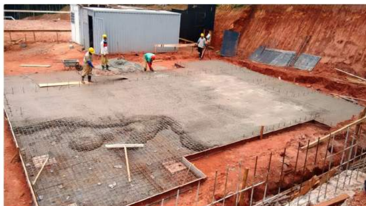
Figura 25 - Concretagem do radier Fonte: Tecverde Engenharia S/A
