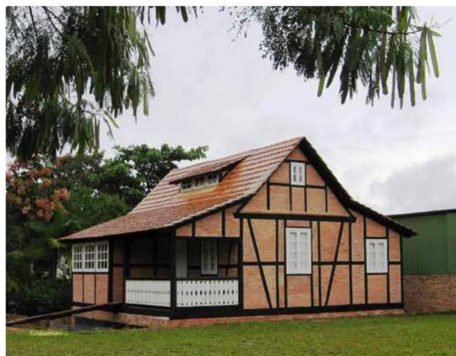
Figura 1 – Casa no Sistema Enxaimel localizada no estado de Santa Catarina, Brasil.
