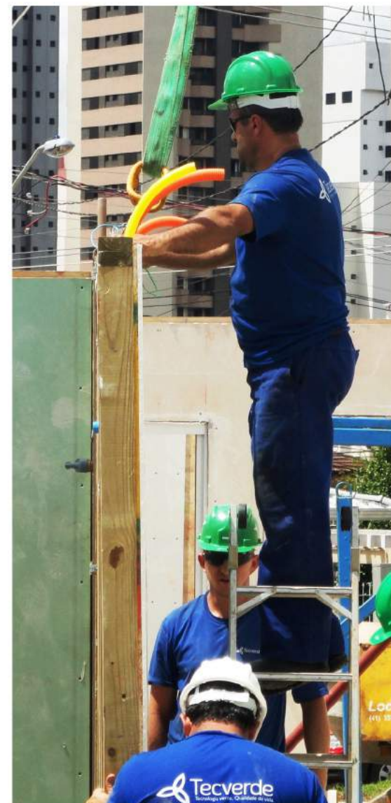
Figura 34 – Organização dos conduítes após a montagem dos painéis Fonte: Tecverde Engenharia S/A
