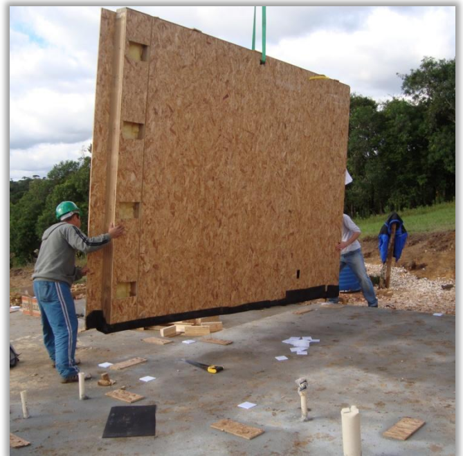
Figura 3: Instalação de painel de parede
