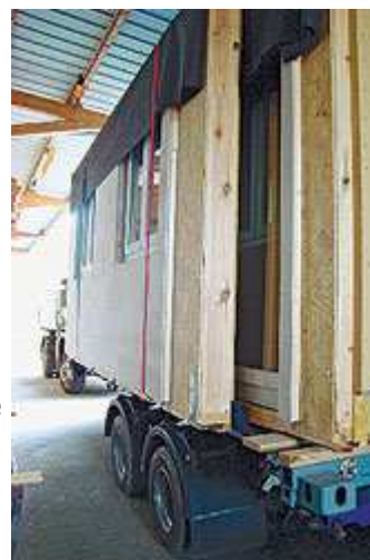
Paredes pré-montadas prontas para serem transportadas por caminhão
